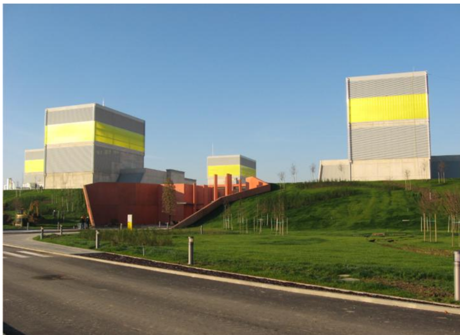
La collina artificiale e le torri di ventilazione
